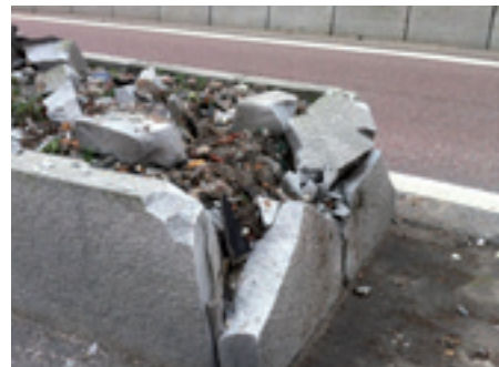
Granitmur är en typ av "räcke" ingen vill köra in i. Ett exempel på när gestaltning prioriteras före trafiksäkerhet.
